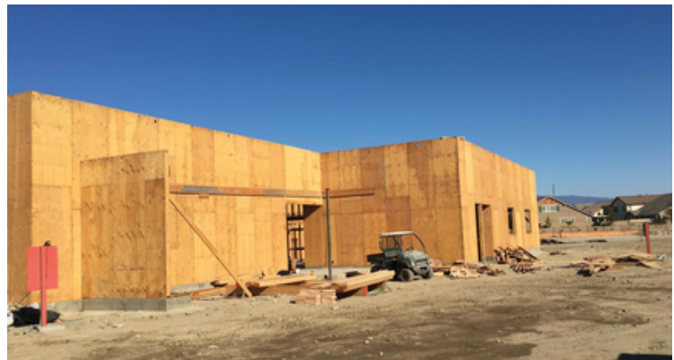
Area A-D Framing
